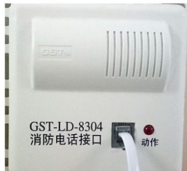
8304 消防电话接口
