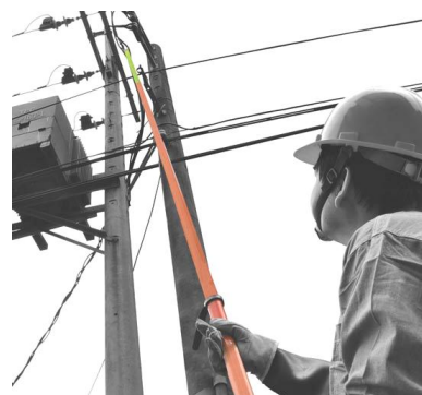
图 6-8 高压验电器的使用
